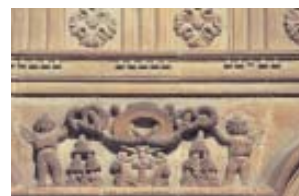
Detalle de la fachada.
